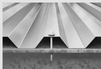
Fissaggio su metallo
